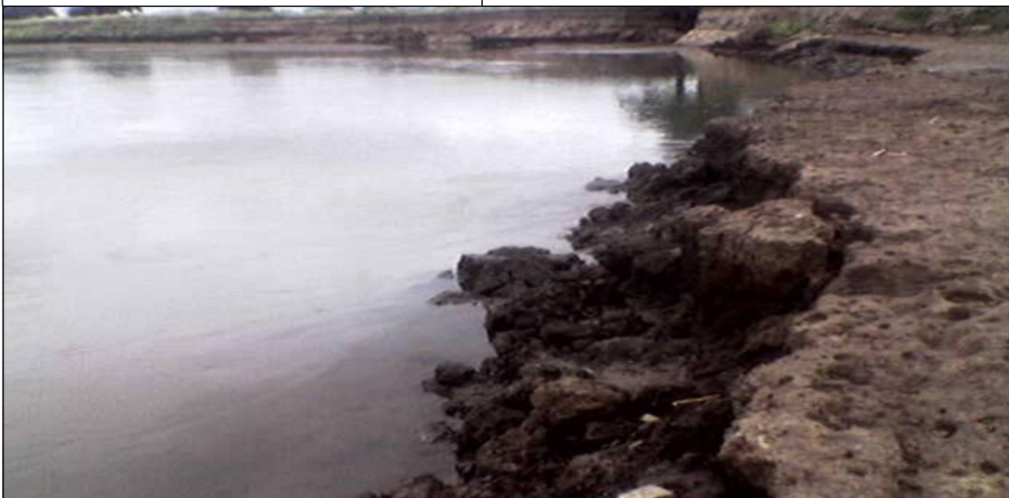
Acção corrosiva, corrosiva e impacto hidráulico no rio Revúbue
