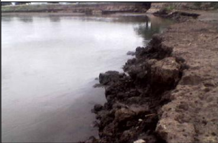
Acções corrosiva, corrosiva e impacto hidráulico no Revúbuè
